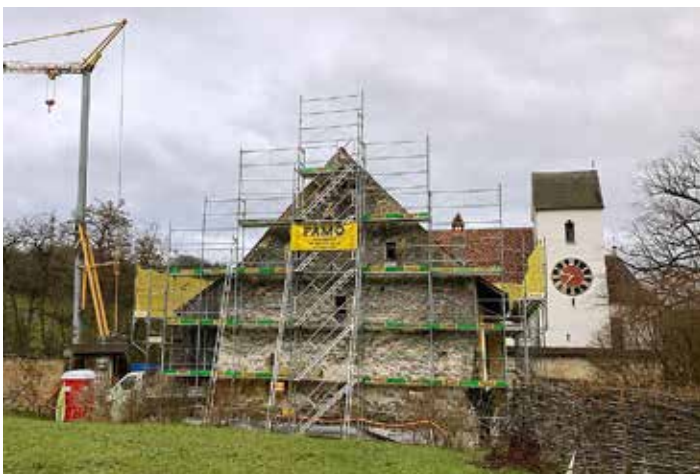
Umbau Pfarrscheune Wölflinswil
