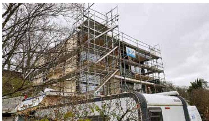
Neubau 3-FH in Rohr Aarau
