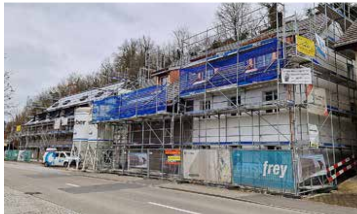
Neubau 2-MFH in Wölflinswil
