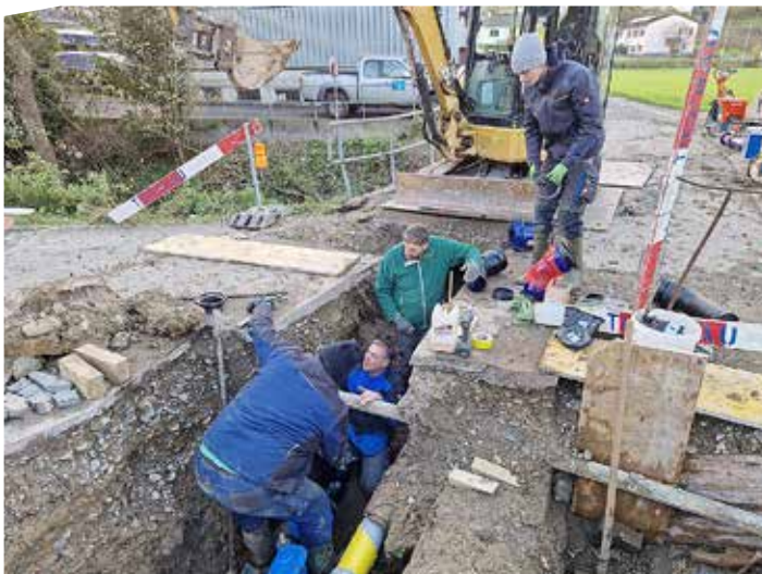
Wasserleitungsersatz Huebmet Wölflinswil
